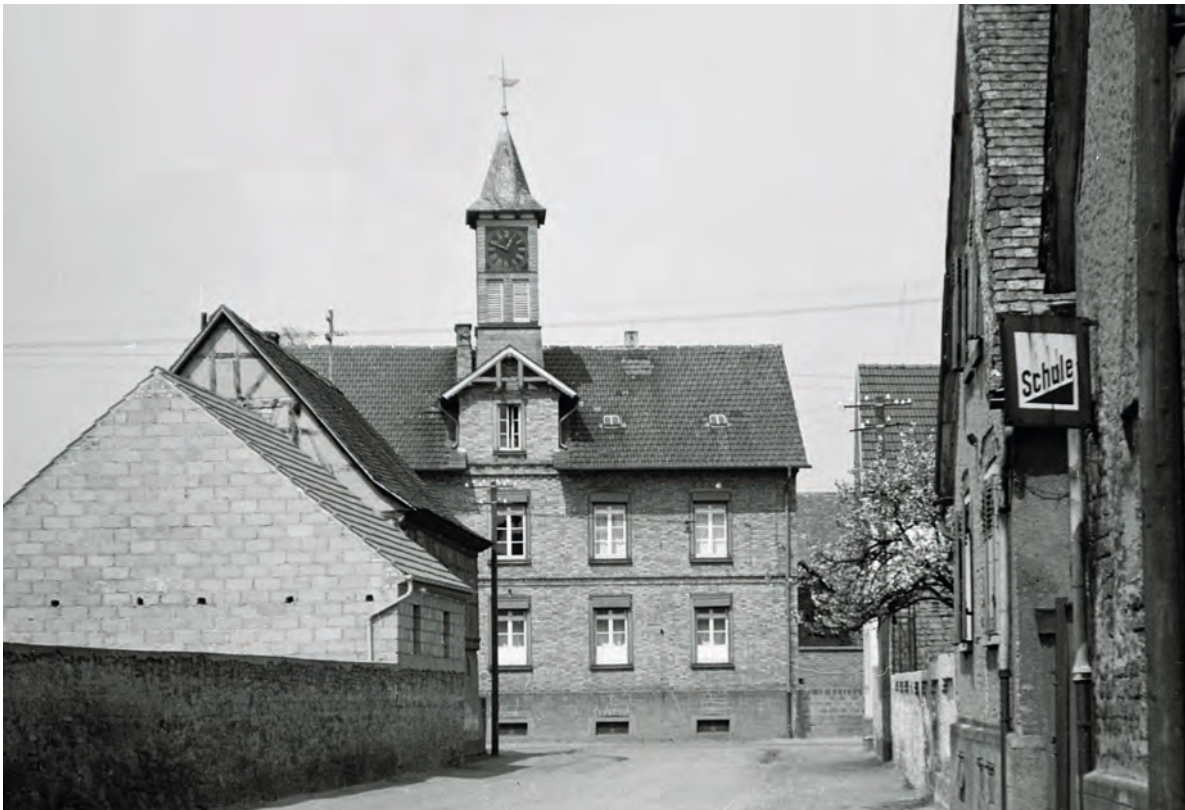
Schulhaus mit Uhrturm von der Borngasse aus, späte fünfziger Jahre (Foto: HGV-Archiv)
